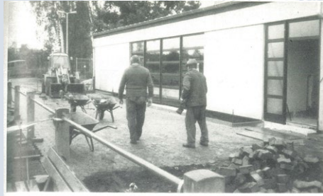
Im Juli begannen die Aufräumungsarbeiten vor dem Bau
